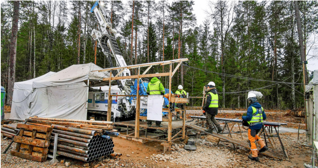
Kaldpuuraugu rajamine Jõhvi Magnetanomaalia. Foto EGT.
